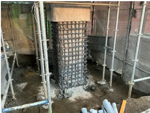
復旧状況 柱 鉄筋修復後 （12 月 19 日撮影）
