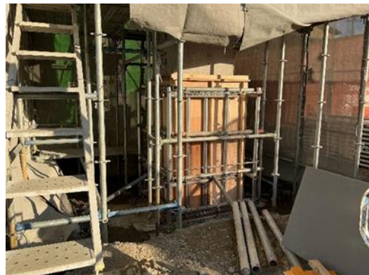
復旧状況 柱 モルタル充填後 （12 月 22 日撮影）
