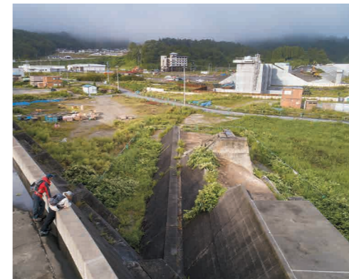
田老町、津波で倒壊した防波堤やホテルと、新しく建設される防潮堤
